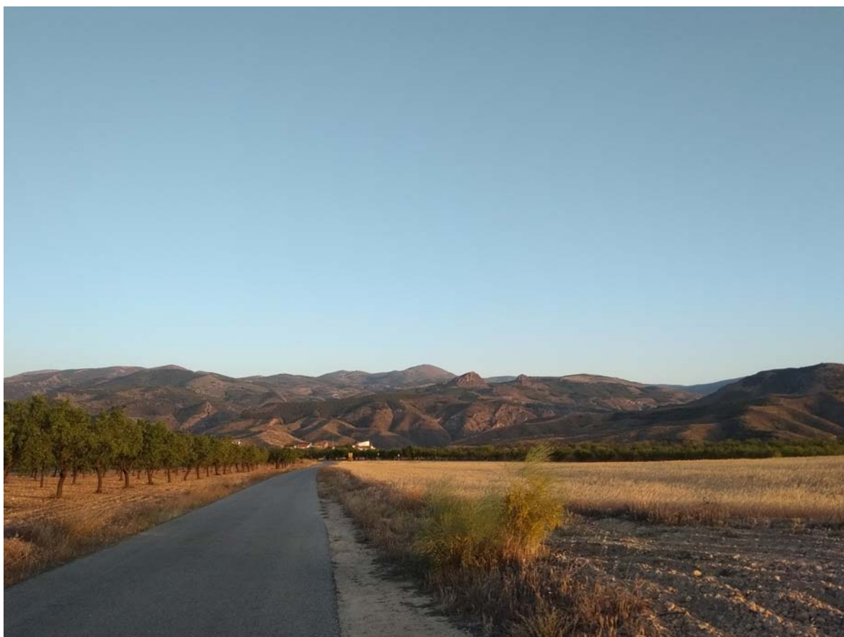
PK 0+900 – Limpieza, desbroce y consolidación de cunetas.
