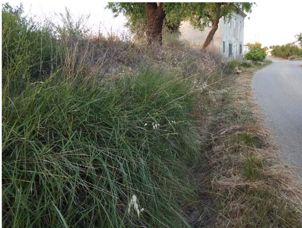
PK 1+700 - Limpieza y desbroce de cunetas. Canalización de acequia.
