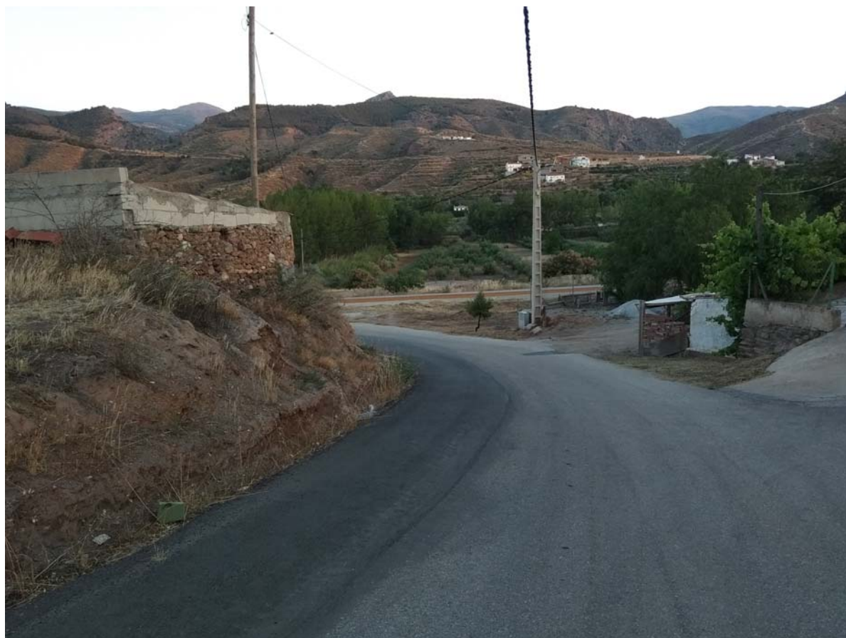
PK 2+800 – Parchado reciente para ensanche de firme en curva. Limpieza, desbroce y reperfilado de cunetas.
