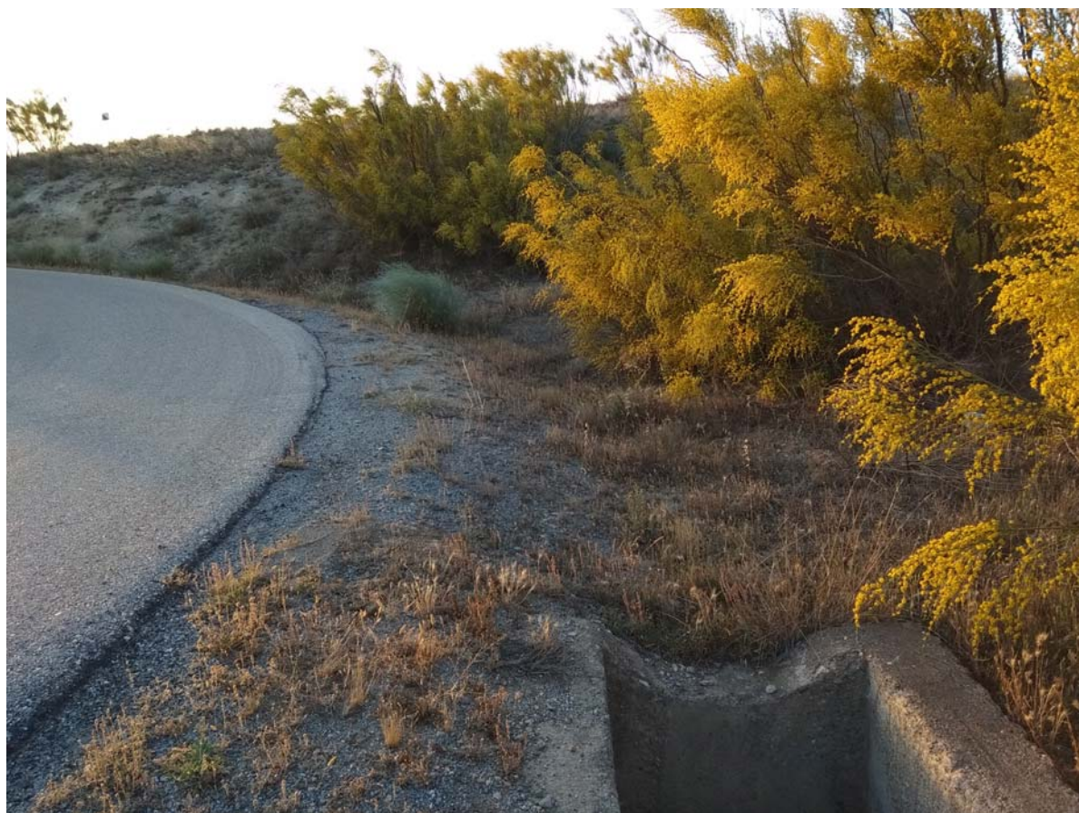
PK 0+500 – Estado actual de caño de entrada, limpieza, desbroce y perfilado de cunetas y caño.
