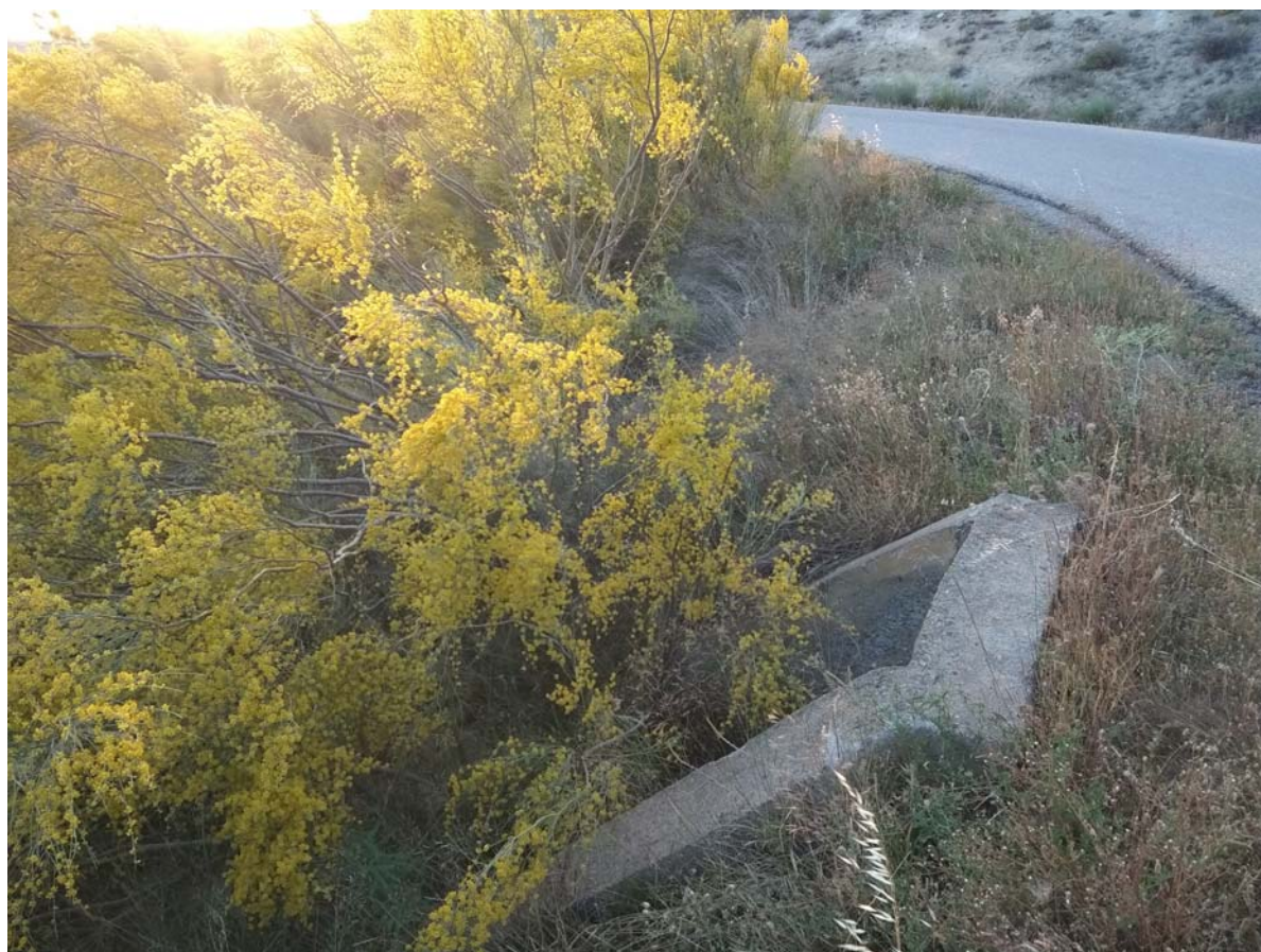
PK 0+500 – Estado actual de caño de salida, limpieza, desbroce y perfilado de cunetas y caño.
