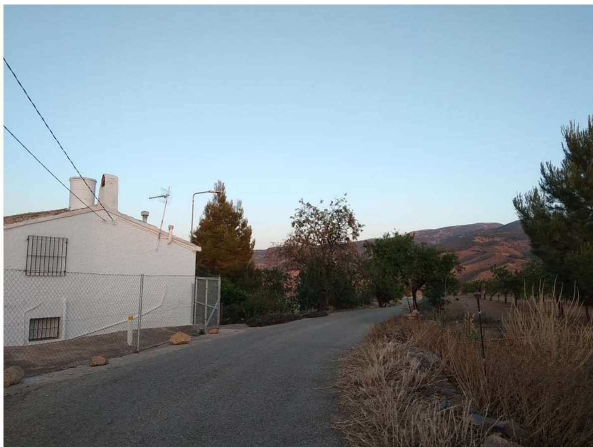
PK 2+800 - Limpieza y desbroce de cunetas. Instalación de señalética curva peligrosa.
