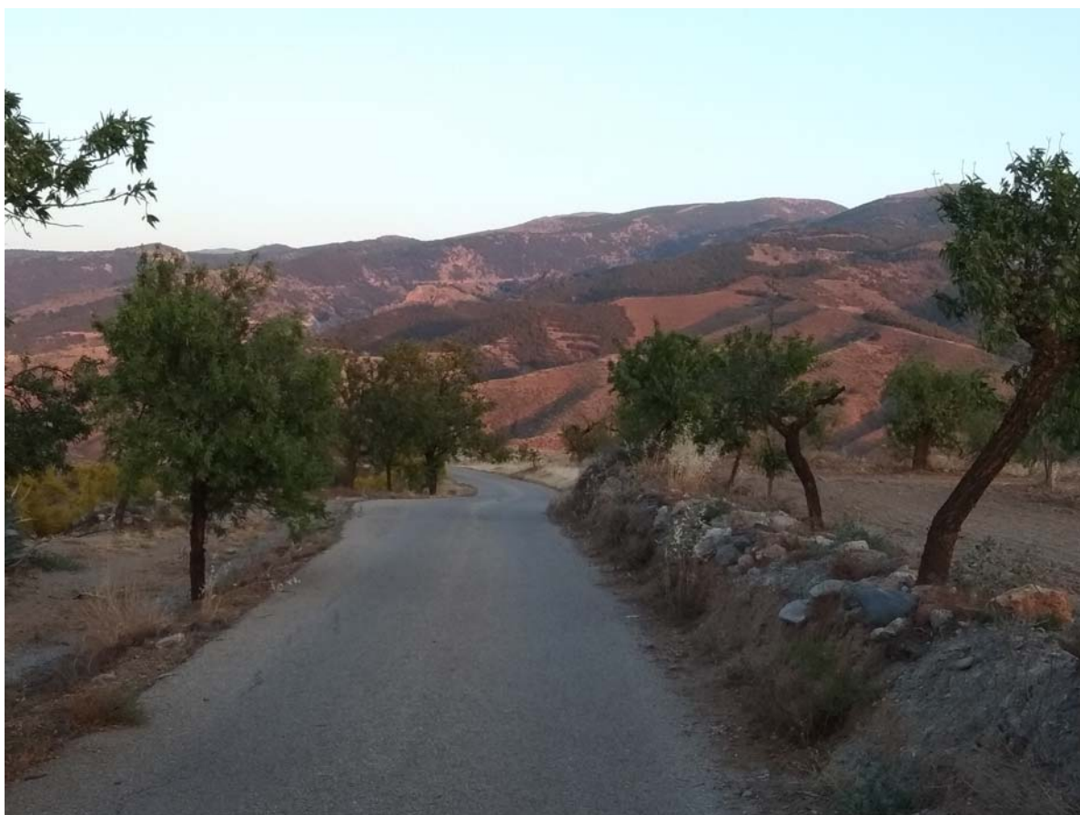
PK 2+100 - Limpieza y desbroce de cunetas.
